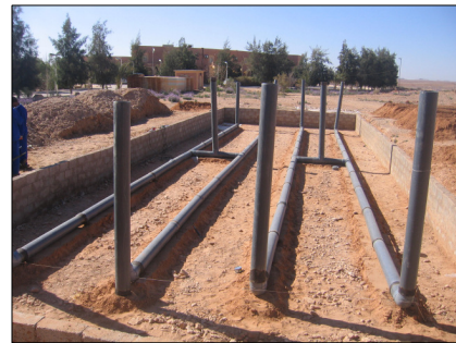
Fig. 3 Système de stockage à lit de galets (avant la mise en place la terre végétale)
